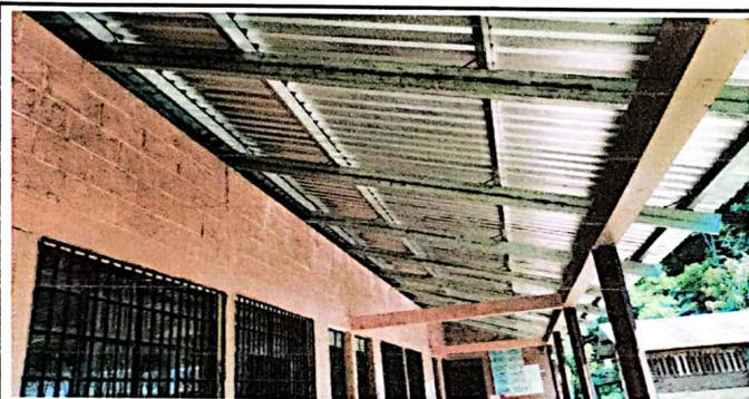
Foto 3: Se observa la sustitucion de estructura y techo en mal estado a metal.
