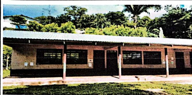
Foto1: Se observa cómo quedó la sustitucion de la estructura de costaneras de madera en mal estado a metal y el techo
